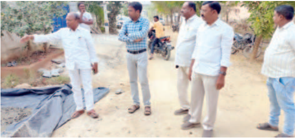
సిసి రోడ్డు నిర్మాణ పనులను పరిశీలిస్తున్న మున్సిపల్ చైర్మన్ రాజమౌళి
